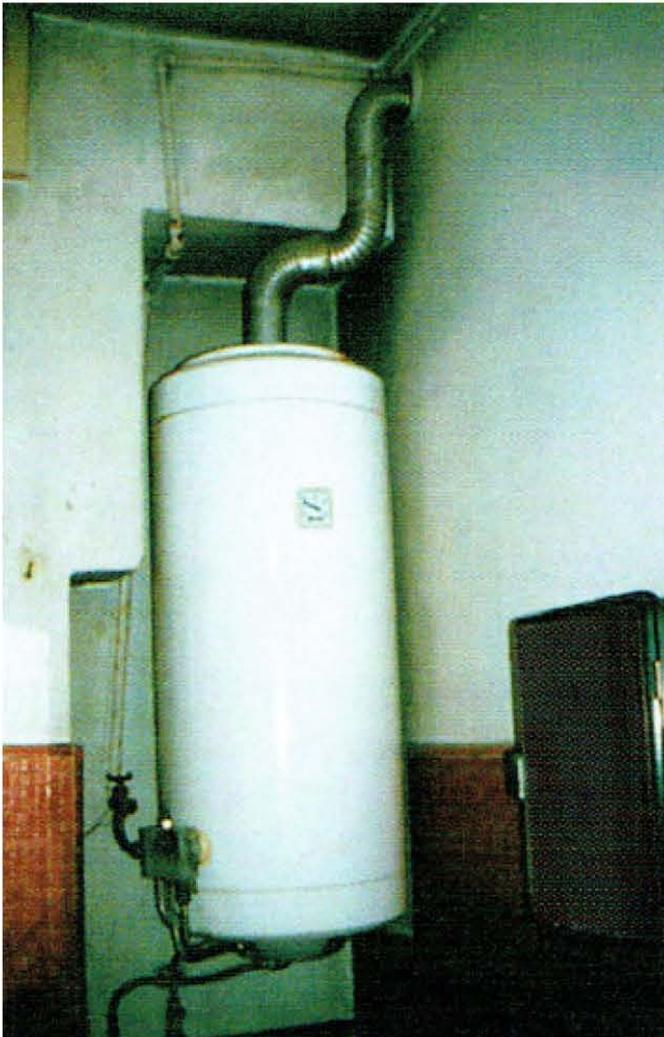
*Boiler a gas installato in bagno. Lo scarico fumi è stato eseguito in modo irregolare.*
