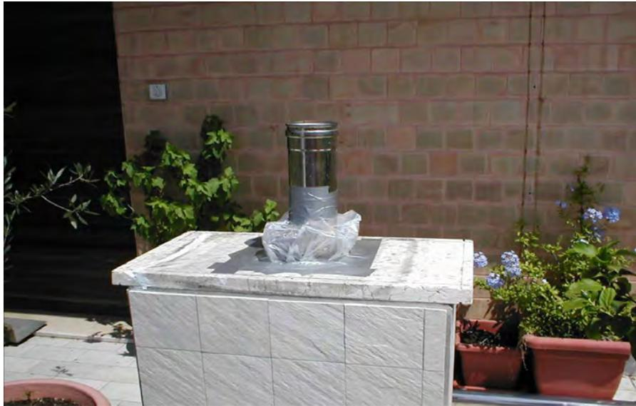
**Fig. 5 - Scarico di un boiler sul terrazzo di un'unità abitativa**
