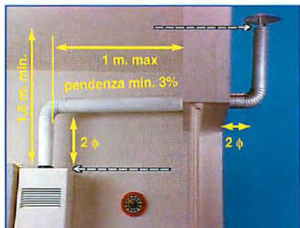
► Non è ammesso convogliare due apparecchi in un unico collettore di scarico dei fumi direttamente all'esterno.
