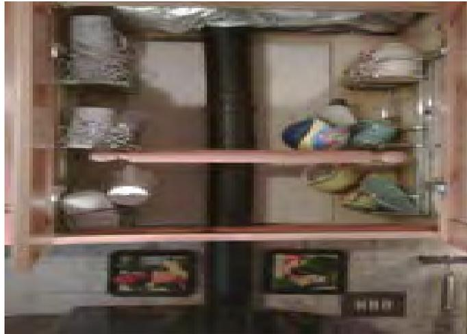
Lo scarico dei fumi di una stufa a pellet passante attraverso un mobile in legno forato al centro ma privo di alcun isolamento termico è una situazione pericolosa a causa delle elevate temperature della canna fumaria, vicinissima, se non a diretto contatto, con materiali combustibili/inflammabili senza alcuna protezione.
