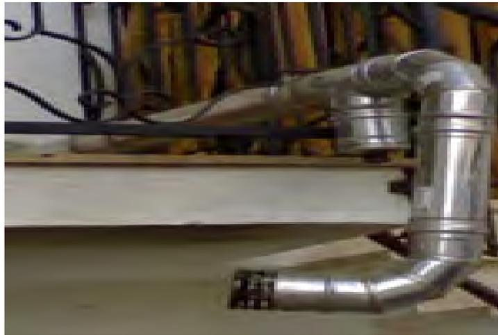
In questa installazione lo scarico dei fumi di una stufa a pellet è, nella prima parte, completamente orizzontale, per poi, addirittura, inclinarsi verso il basso.
