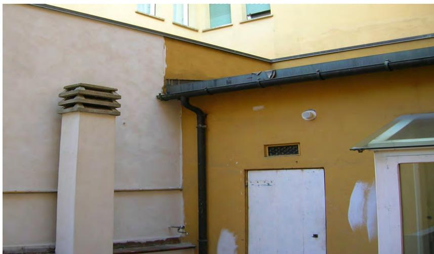
**Fig. 4 - Scarico del generatore sul terrazzo di un'unità abitativa**
