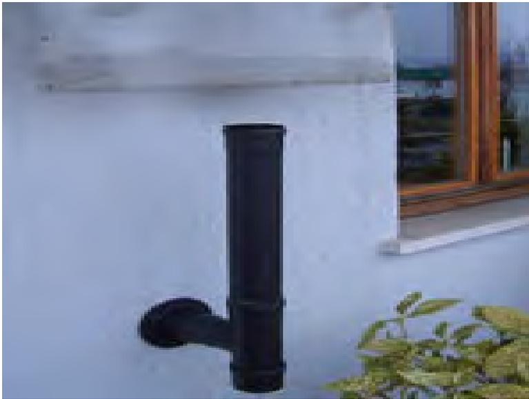
La fotografia riporta uno scarico a parete per stufa a pellet che, come è stato detto in precedenza, è vietato dalla norma UNI 10863, con l'aggravante di risultare anche senza alcun terminale anti-intrusione.
